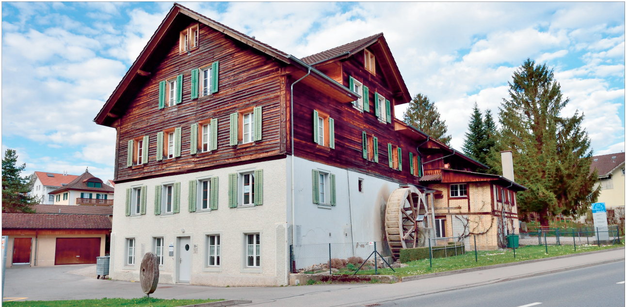
Die Mühle in Buttisholz wurde 1993 durch die Genossenschaft Gemeinschafts-Antennenanlage käuflich erworben.
