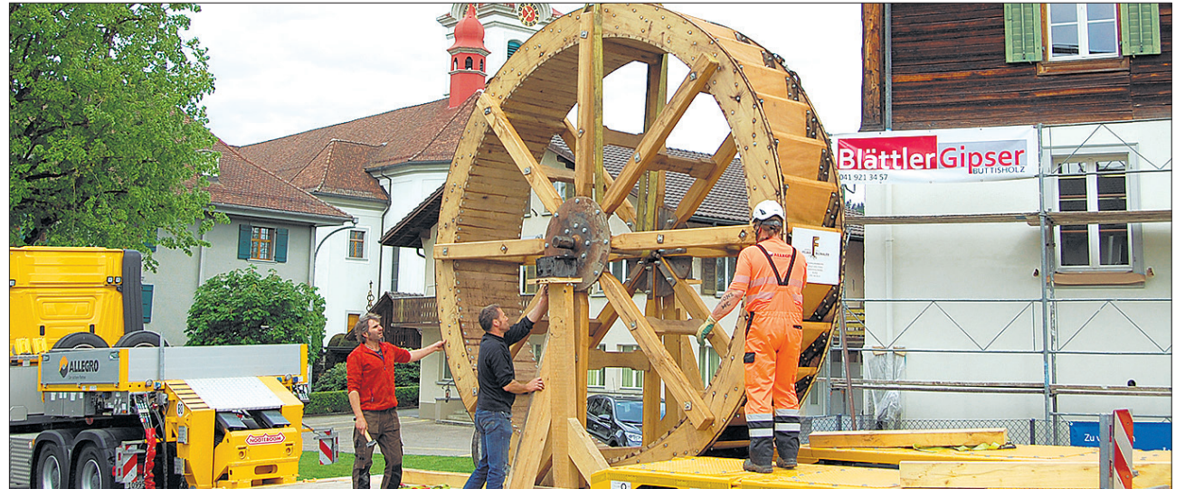
Das neue Wasserrad wird vor der Dorfmühle Buttisholz wieder eingesetzt. Foto Willi Röllli
