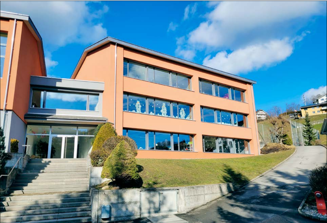
Das Schulhaus Unterdorf in Werthenstein gehört zur Gemeinde Ruswil. Ab Juni wird es während neun Wochen saniert. Foto zVg
