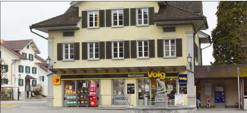
Hinter dem Volg-Gebäude plant die GAB einen Neubau. In dessen Obergeschoss wird die Zahnarztpraxis von Matthias Käch einziehen. Foto Michael Wyss
