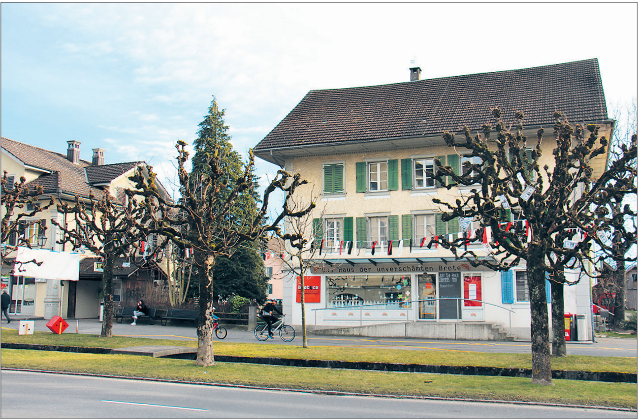
Blick auf das Zentrum «Dorf Süd» in Buttisholz. Dereinst sollen hier lokale Unternehmer ihre Waren anbieten können. Foto zVg
