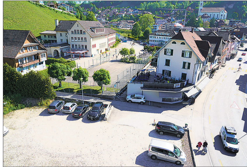
Das Gebiet des Bebauungsplans Entlebucherstrasse befindet sich entlang der Entlebucherstrasse zwischen der Abzweigung Wiggernweg (Schulanlage Rainheim) und der Abzweigung Im Schmitteli. Foto zVg
